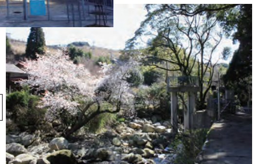
泊野川水力発電所取水口と山桜
