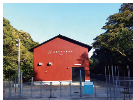
泊野川水力発電所建屋
