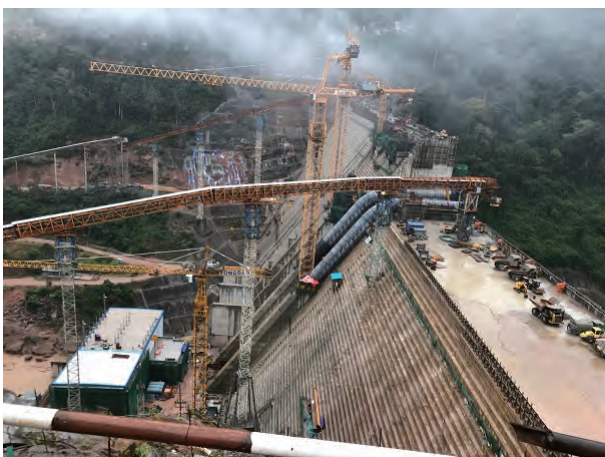
上：日本の援助で6基目の発電機の工事が進むNam Ngum1発電所 下：同じくNam Ngiep1発電所
