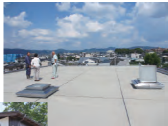
イサク事業所の屋上、太陽光発電にはうってつけ、さて何 kW つけられるのか…
